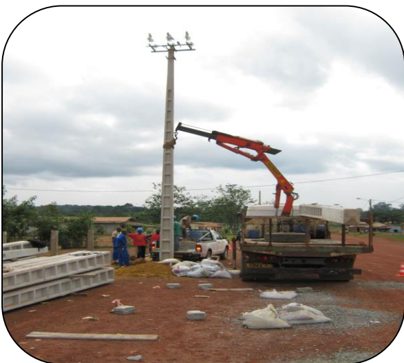
Implantation d'un support en béton armé
