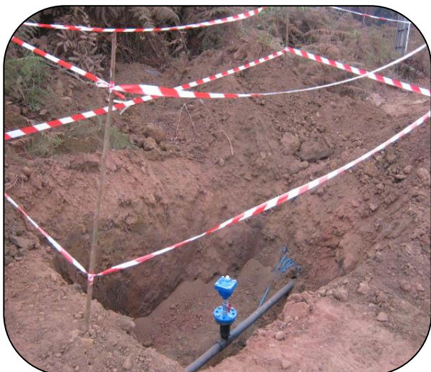
Sécurisation d'une fouille pour regard
