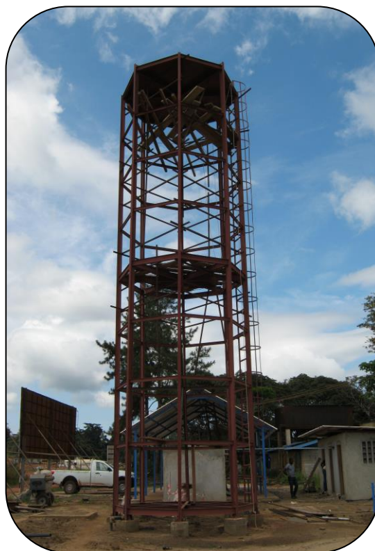
Montage ossature d'un château d'eau
