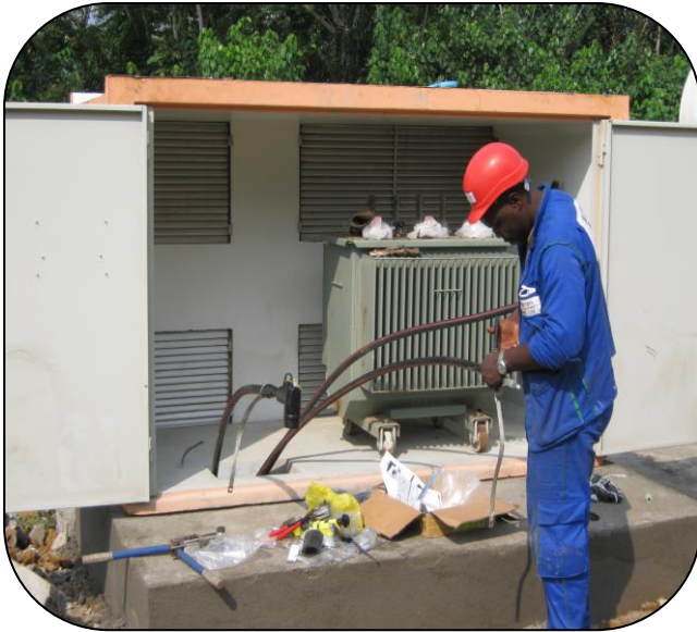
Confection des têtes de câble pour transfo élévateur
