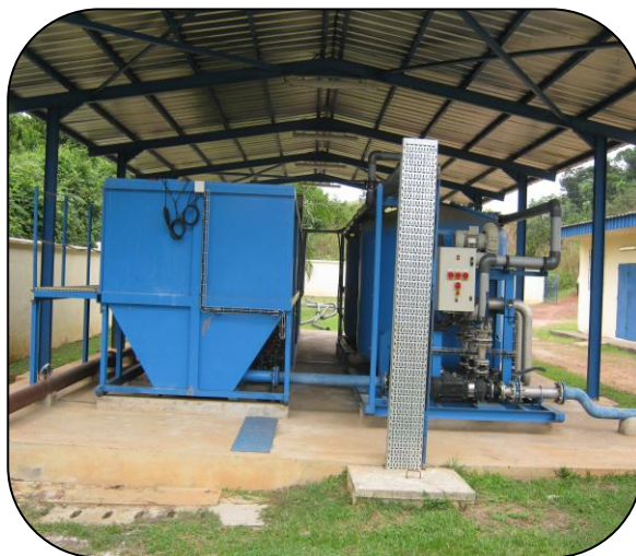
Station de traitement d'eau de 30m 3 /h
