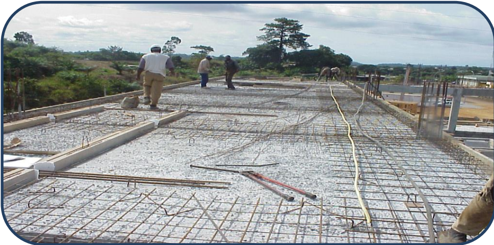
Ferraillage et coulage dalle
