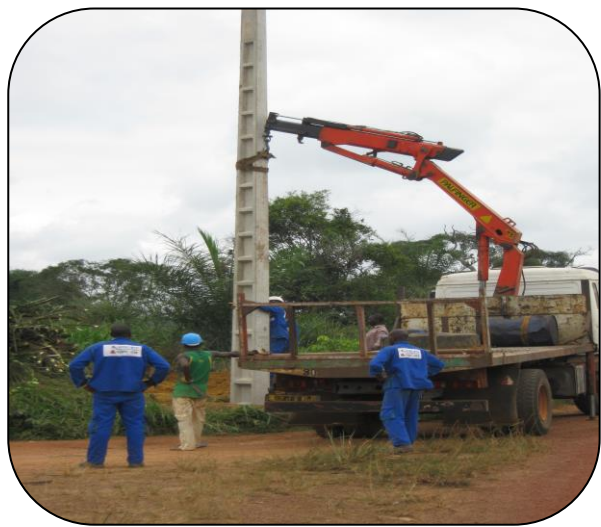
Implantation d'un support en béton armé
