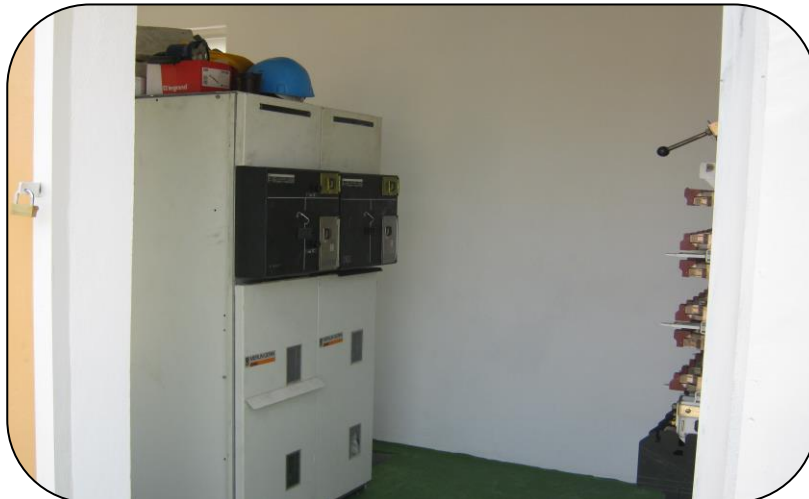
Poste de transformation 20kv/410v
