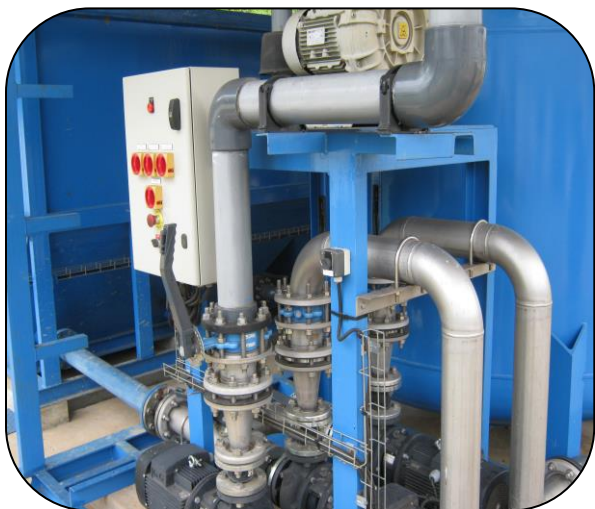
Station de traitement d'eau de 30m 3 /h
