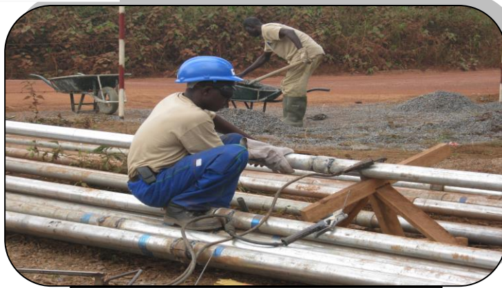
Préparation tuyau galva Ø80 pour la pose d'une conduite de refoulement
