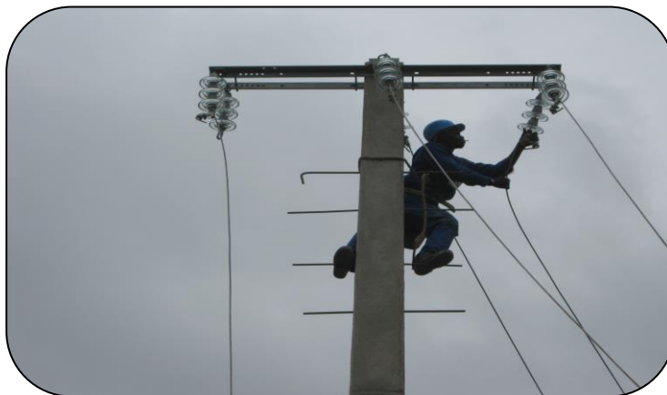
Mise en place d'un réseau 20kv
